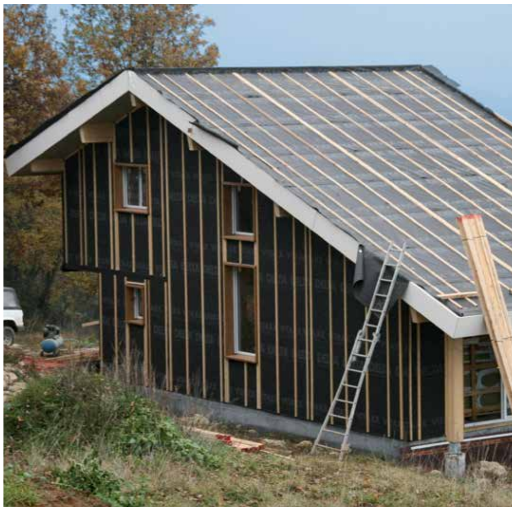
DELTA®-VITAXX PLUS zastosowana na dachu i na fasadzie budynku.
