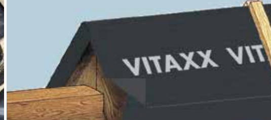
Kalenica dachu zamknięta membraną.
